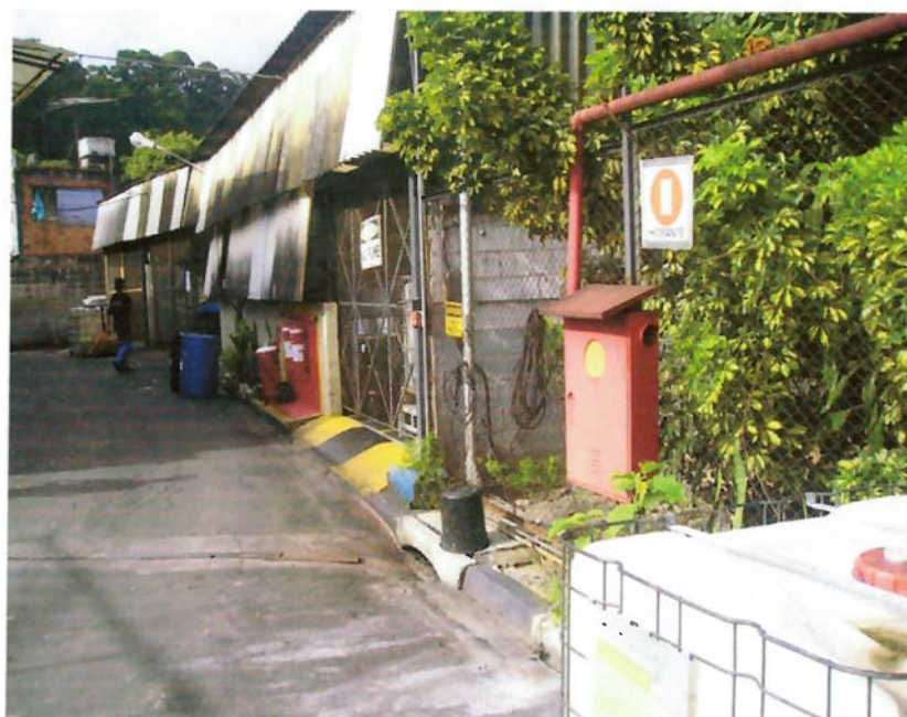
Figura 13 Equipamentos de combate à incêndio dispostos na parte externa do galpão, contendo hidrante e extintores CO 2 .
